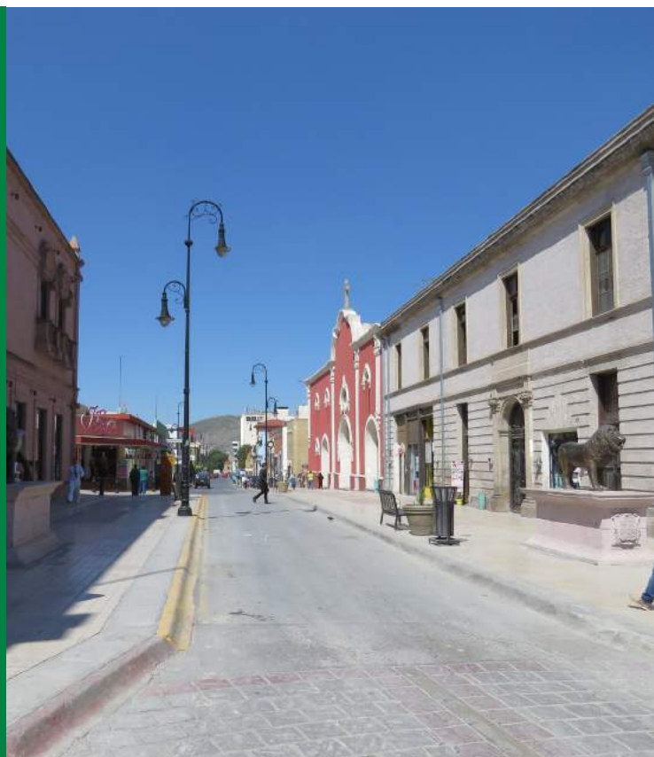
Ampliación de banqueta en la calle Guadalupe Victoria
