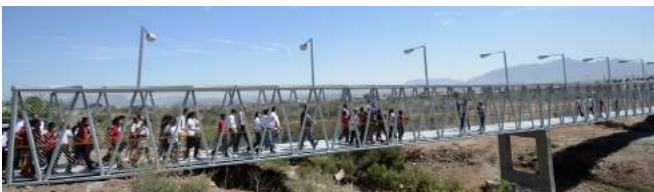
Puente peatonal sobre arroyo
