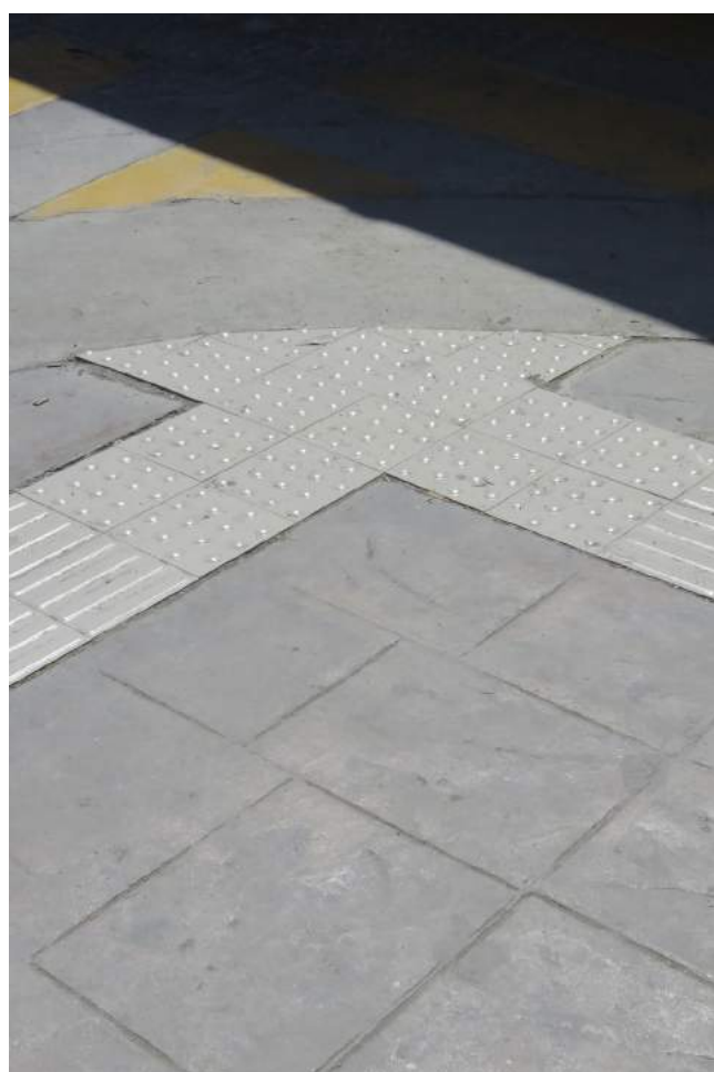
Cruce peatonal con guía táctil en intersección
