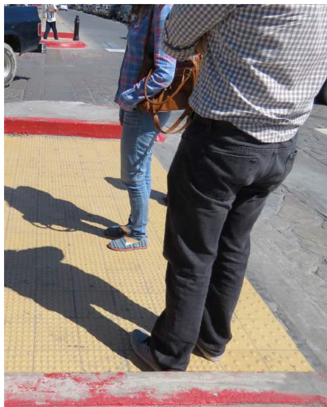
Cruce peatonal con guía táctil en isleta de intersección
